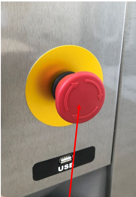
Vérifier le bon fonctionnement des arrêts d'urgence côté sale et côté propre
